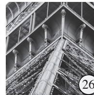
Victor Solano Foto Kvarteret Ödlan Syrgasvägen 7 55302 Jönköping
